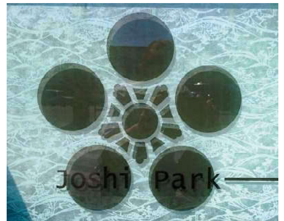
本体：御影石（チャイナグレー）JB+一部本ミガキ仕上 表示：6+12+6 合わせガラス 八尾和紙+シルク印刷 内照式
