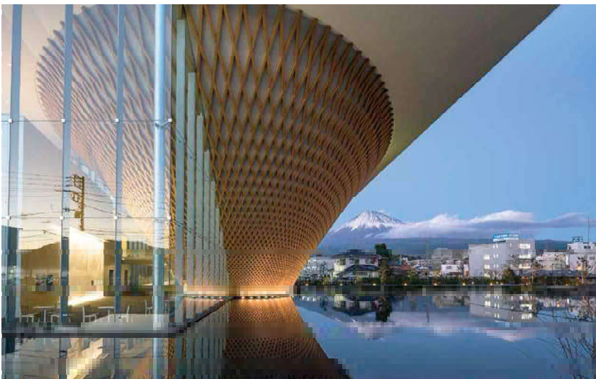
1F カーテンウォール枠
