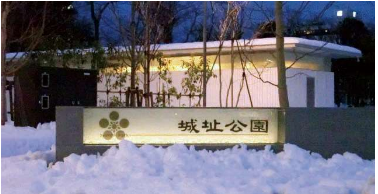
本体：御影石（チャイナグレー）JB+一部本ミガキ仕上 表示：6+12+6 合わせガラス 八尾和紙+シルク印刷 内照式
