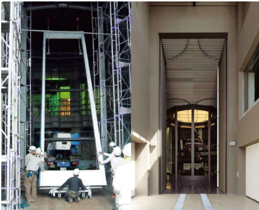
展示ショーケース (SUS304/バイブレーション) / 展示室出入口フラッシュ両開扉 (スチール化粧銅板貼り)
