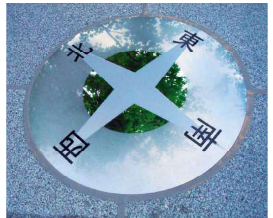
ステンレス方位盤 エッチング仕上
