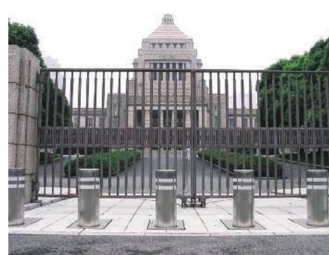
国会議事堂門扉改修 (東京都)
