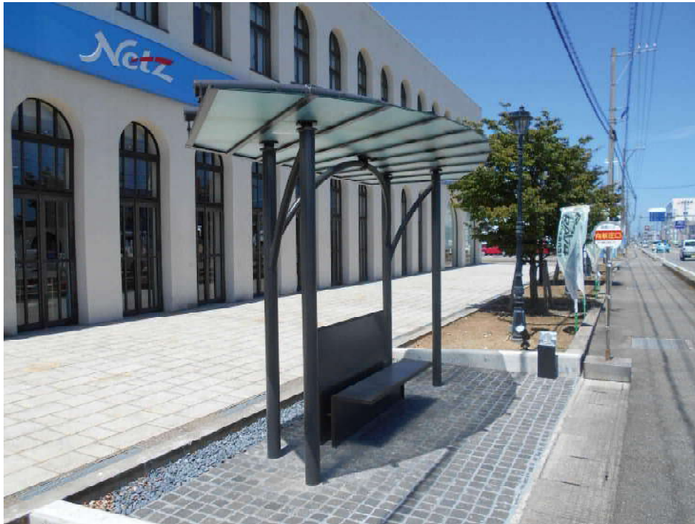
バスシェルター・ベンチ：スチール塗装仕上（艶消しブラック） 庇 合せ硝子
