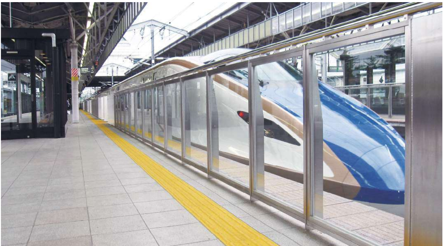
軽井沢駅：新幹線プラットフォーム 固定柵
