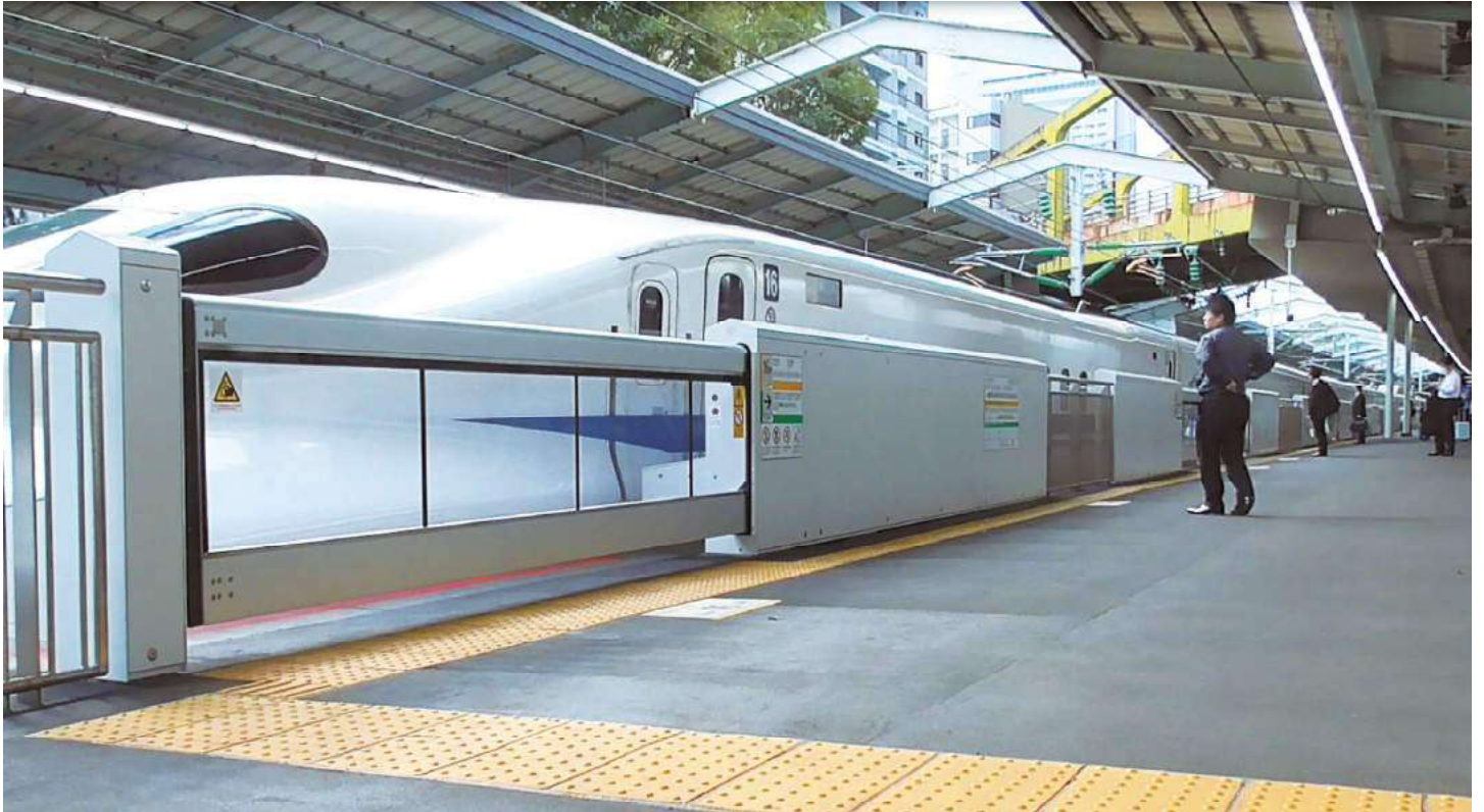
新神戸駅：新幹線プラットフォーム 可動柵
