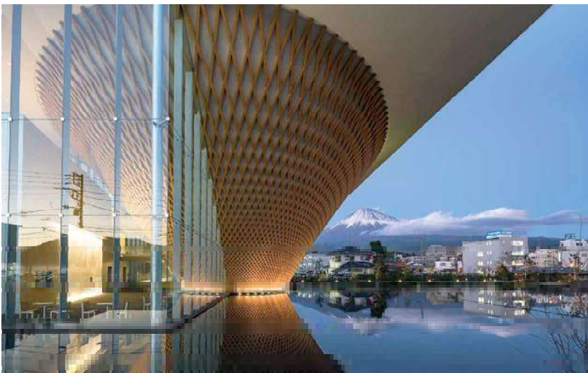
1F カーテンウォール枠
